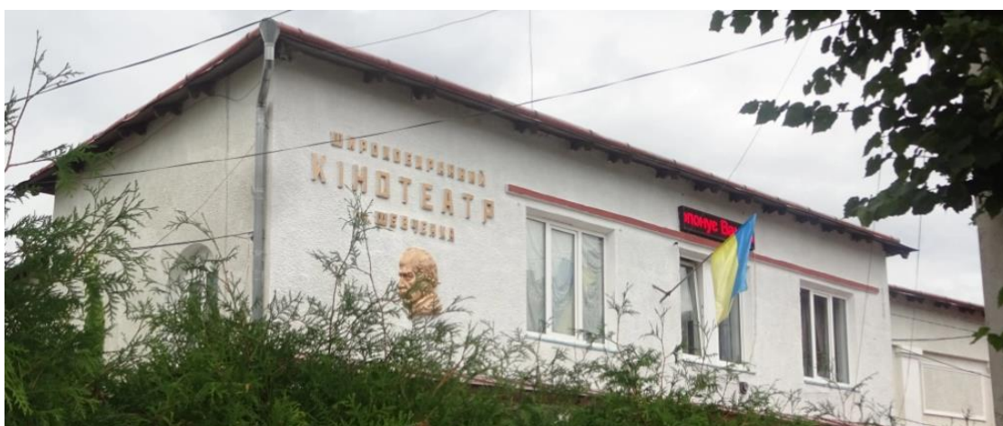
Кінотеатр імені Т. Шевченка, будівля колишньої синагоги, 2017 р. 106
